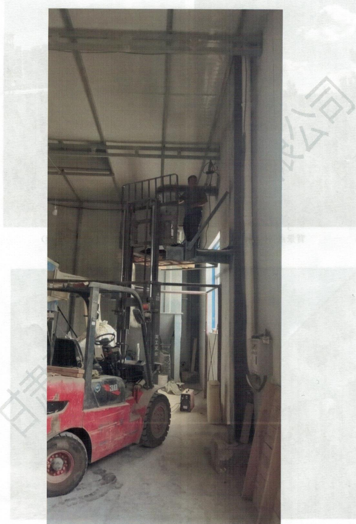
布袋除尘器总排口
