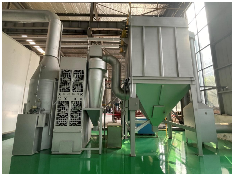
图 4-1 火化、焚烧废气治理措施参考图
