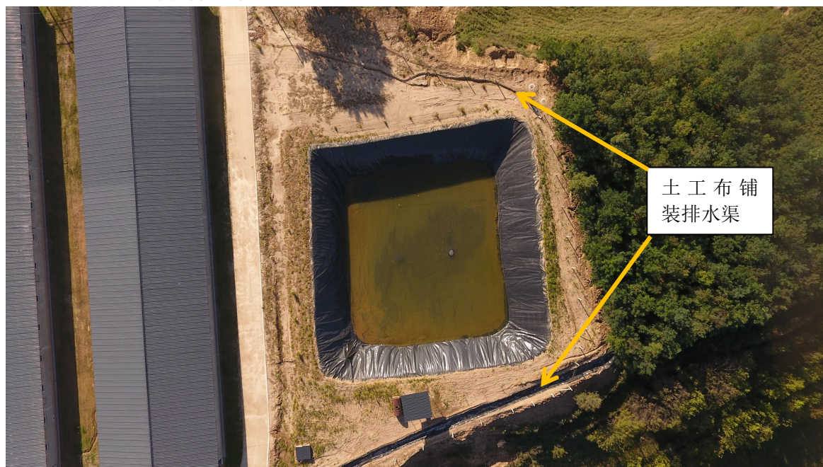
场地两侧贯穿经过的土工布铺装排水渠
