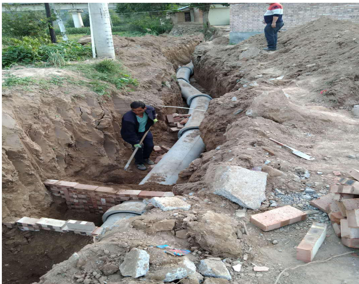
新建雨水排放工程
