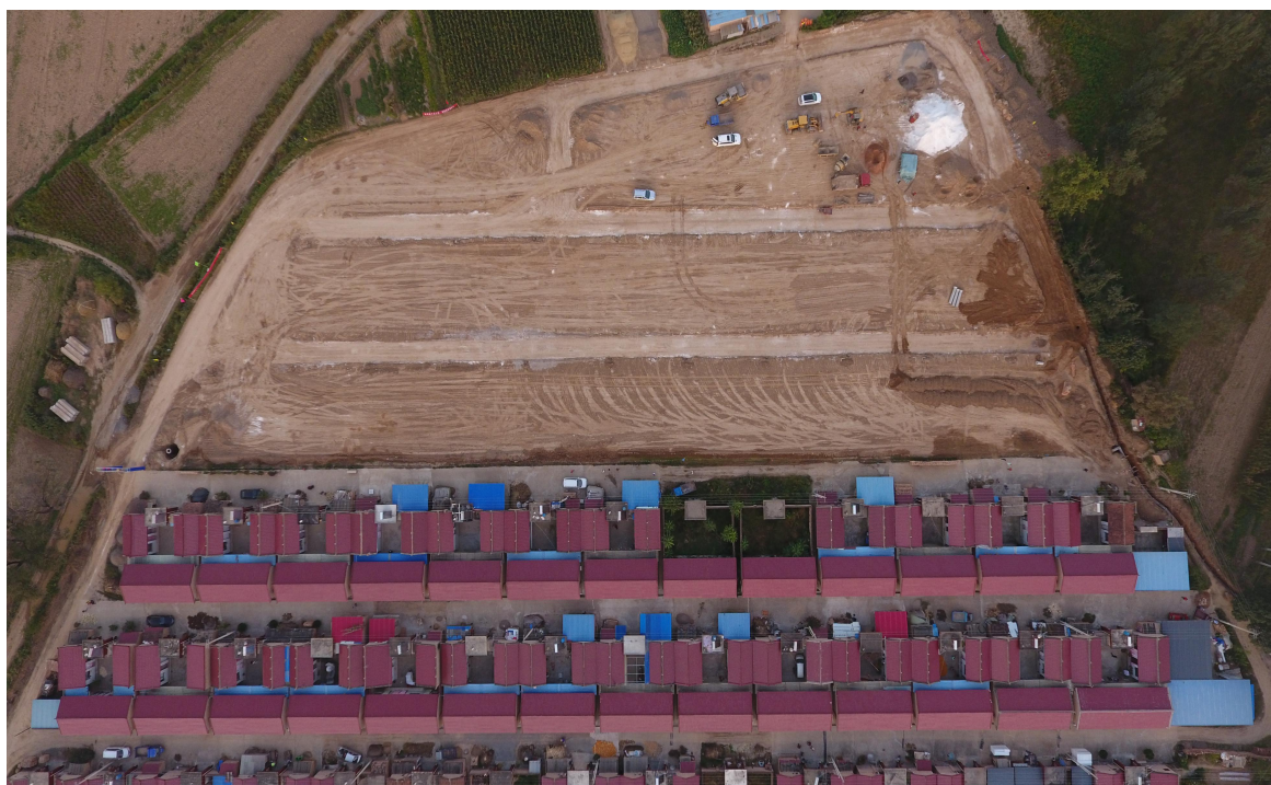
项目场地俯瞰图（照片左侧为北）
