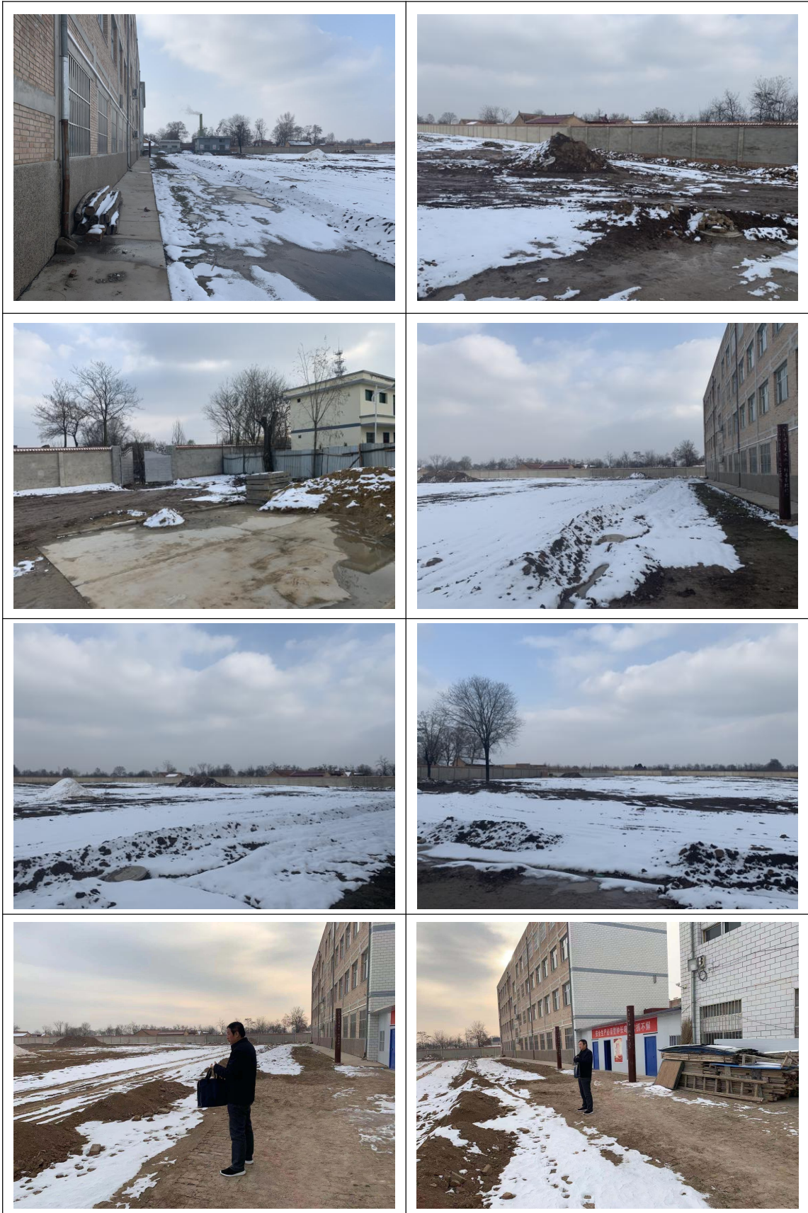
宁县新庄初级中学运动场建设项目现状
