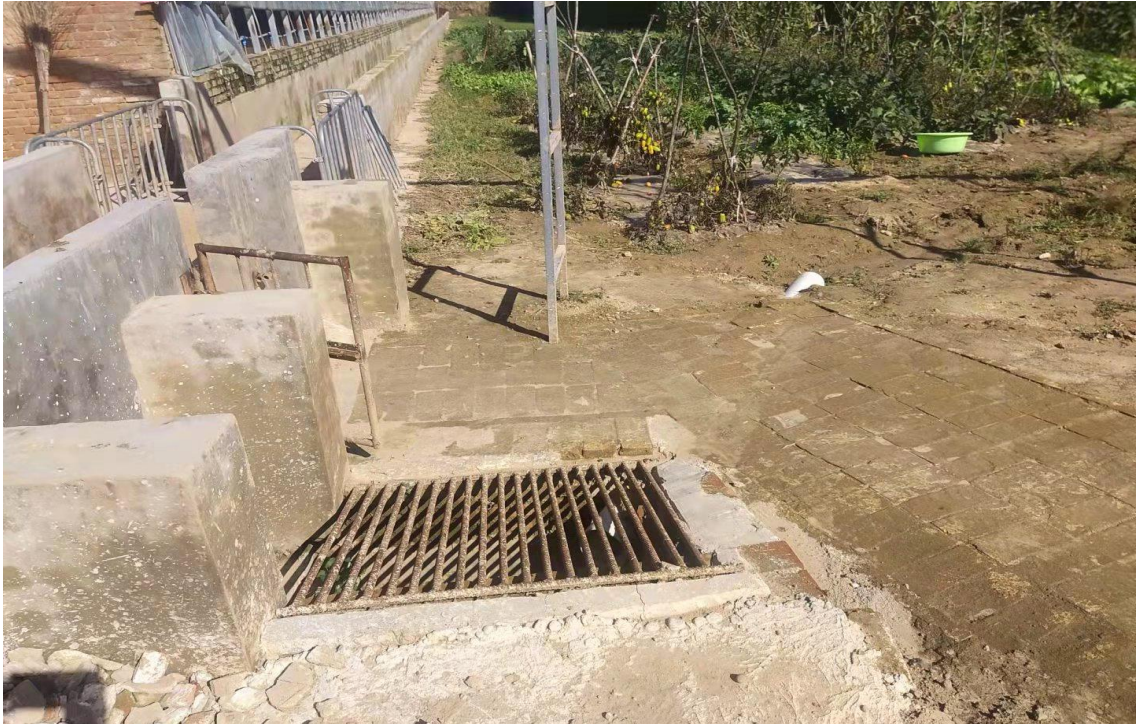
已建成项目区排水沟照片
