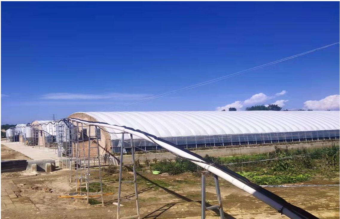
已建成项目区基础设施照片
