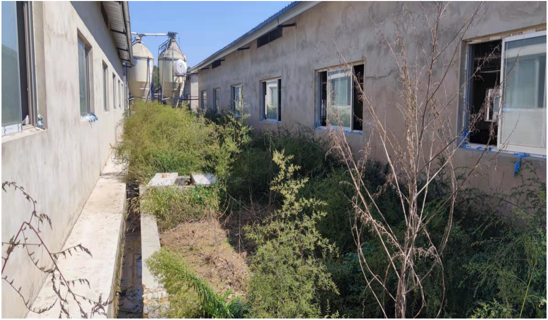
已建成项目区排水沟照片
