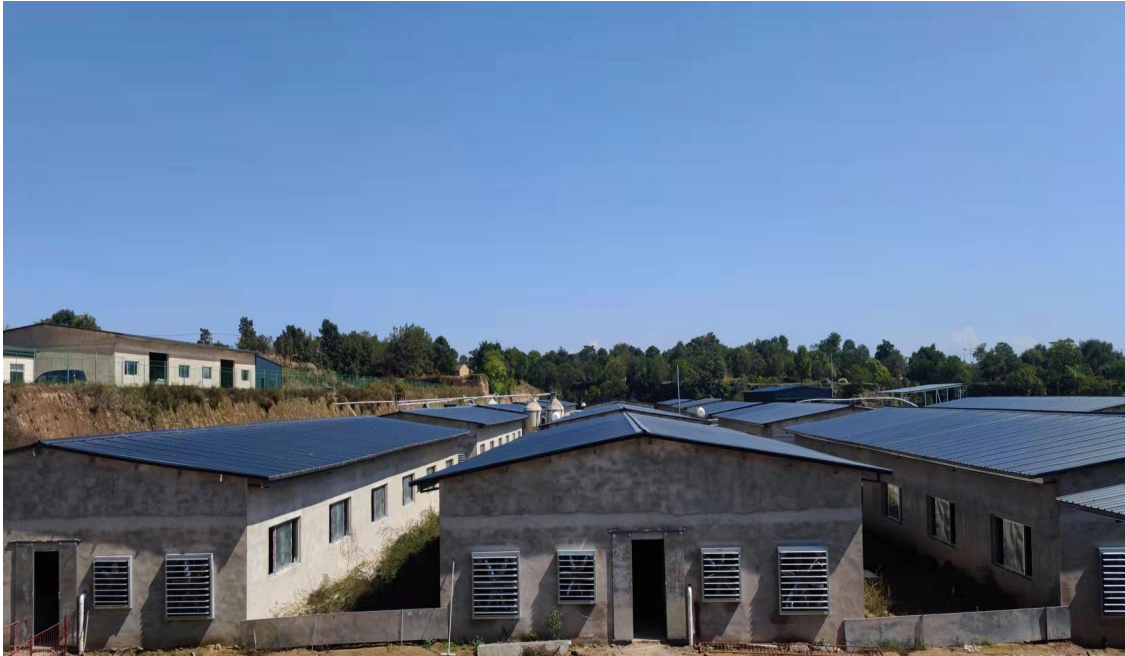
已建成项目区基础设施照片
