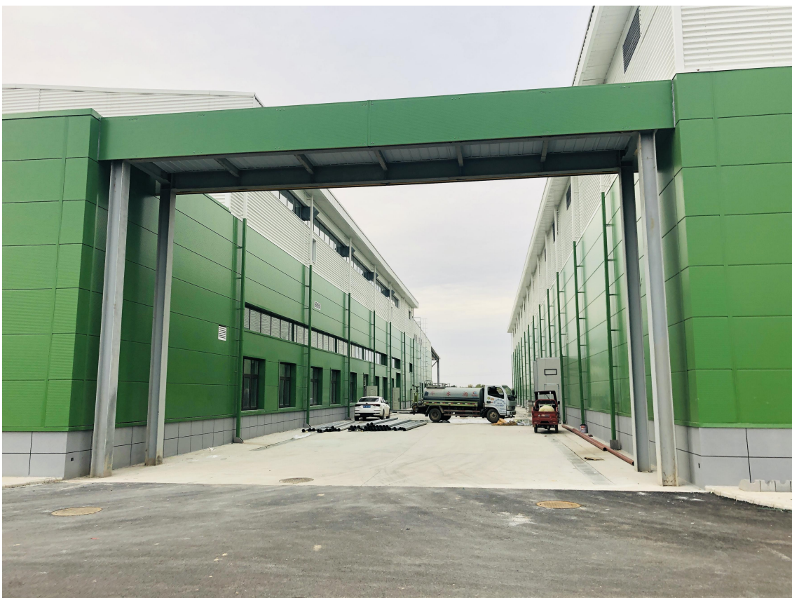
项目区道路硬化照片
