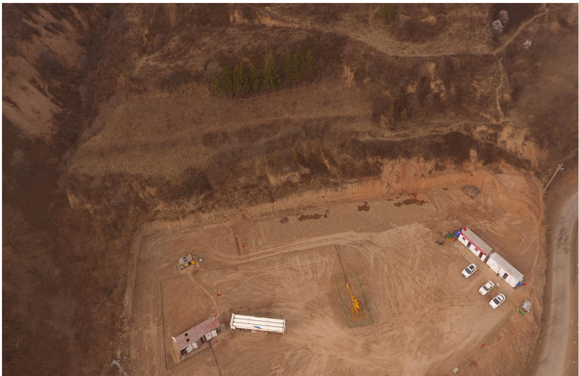
场地西北两侧为山地削坡，削坡顶部植被茂盛
