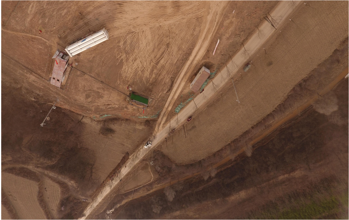
场地南侧为县乡道路
