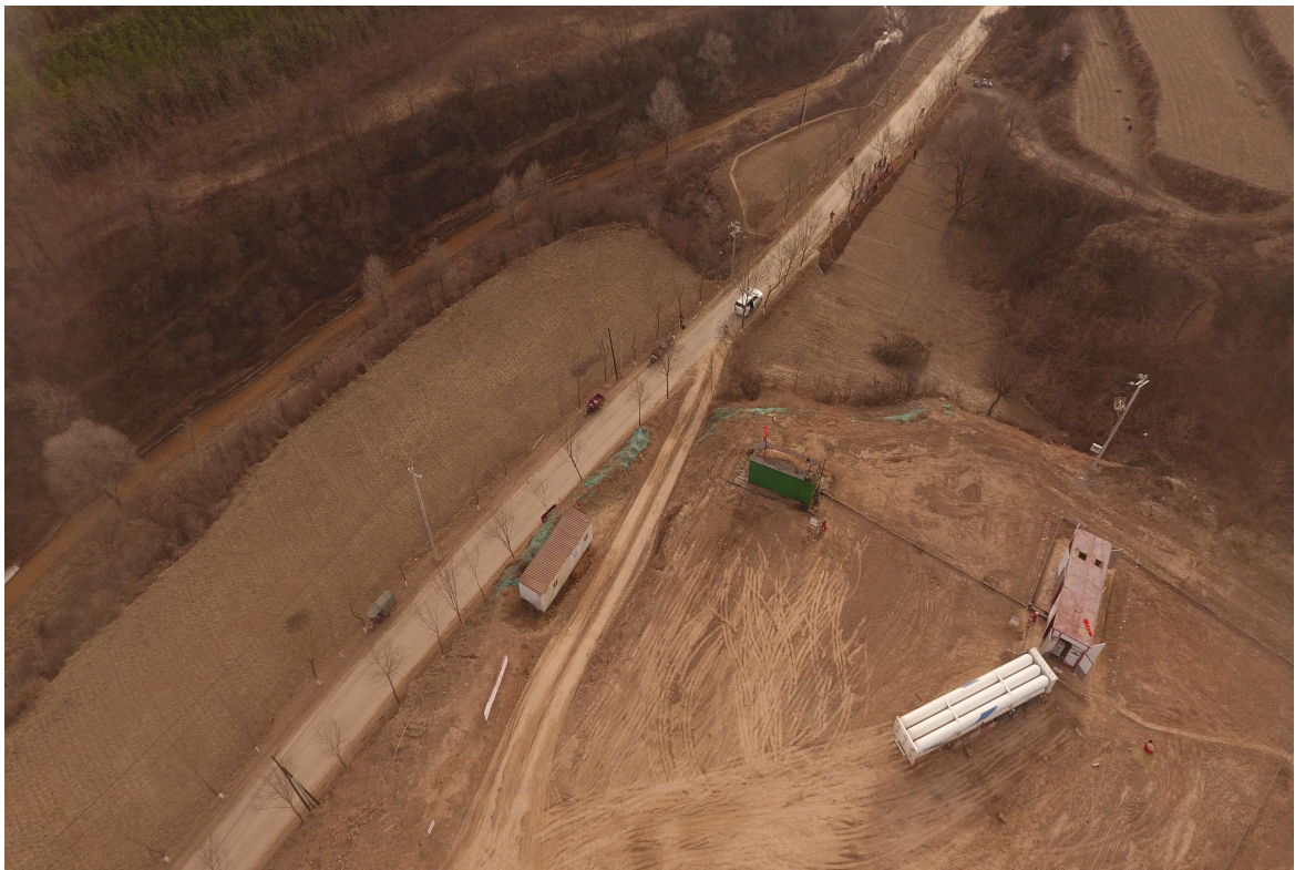
场地西南角新建 50m 进场道路与县乡道连接
