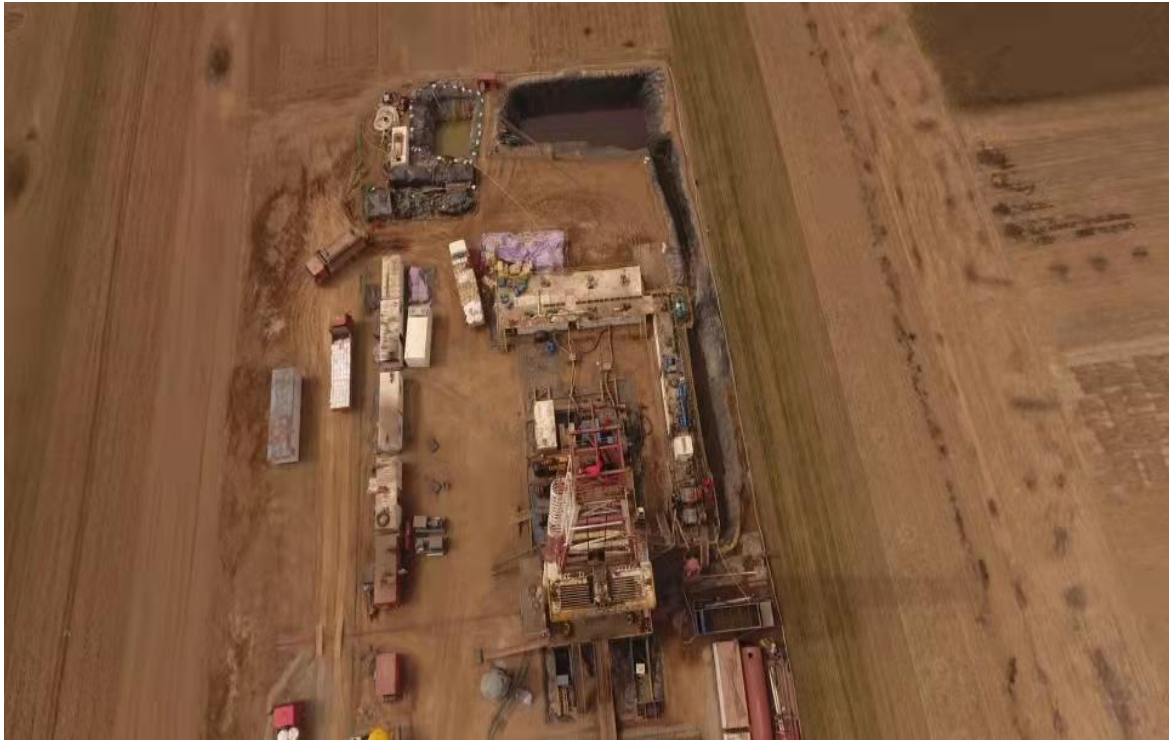
场地东南角修筑油污池、清水池
