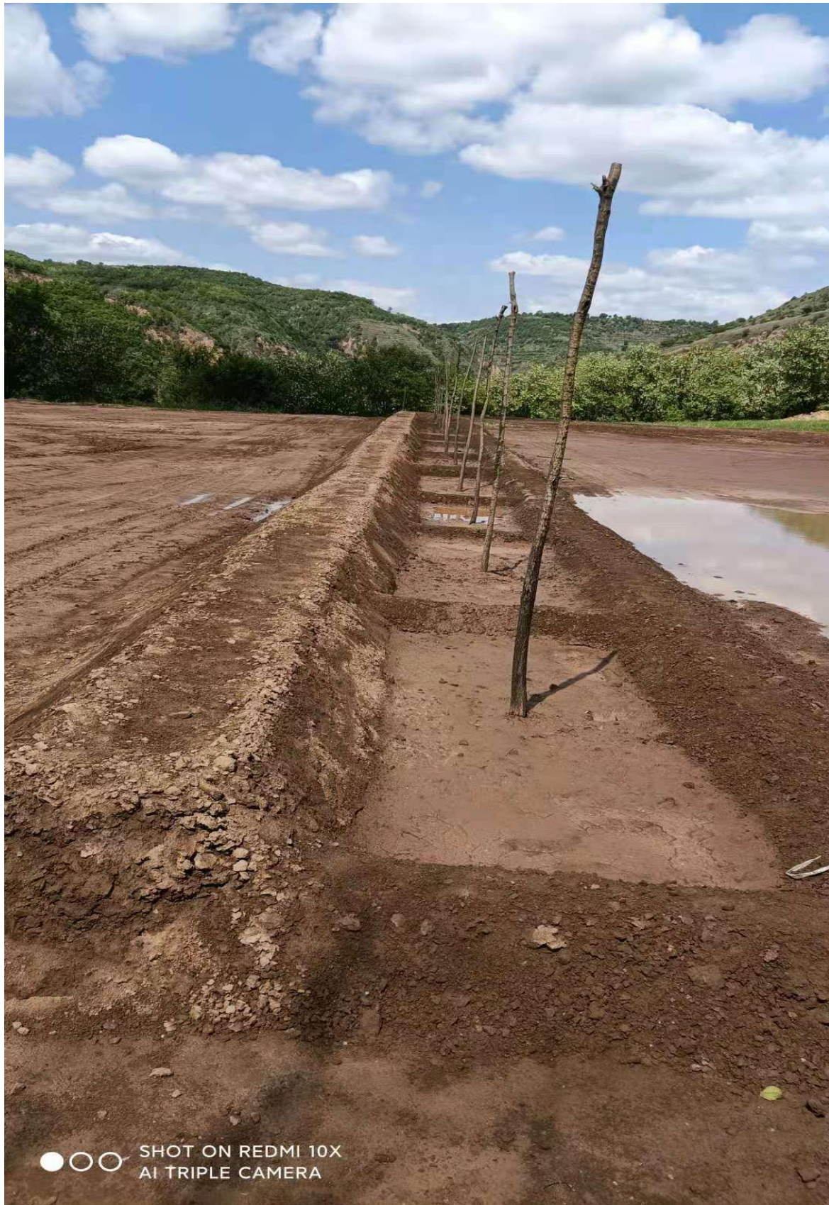
挡水埂、水平阶整地及栽植乔木（示意）
