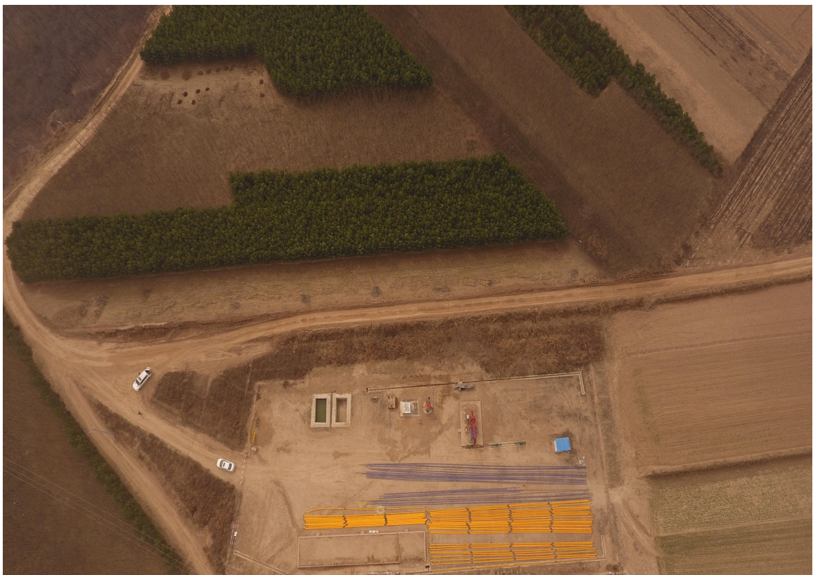
场地内已建有清水池，界定为水土保持措施
