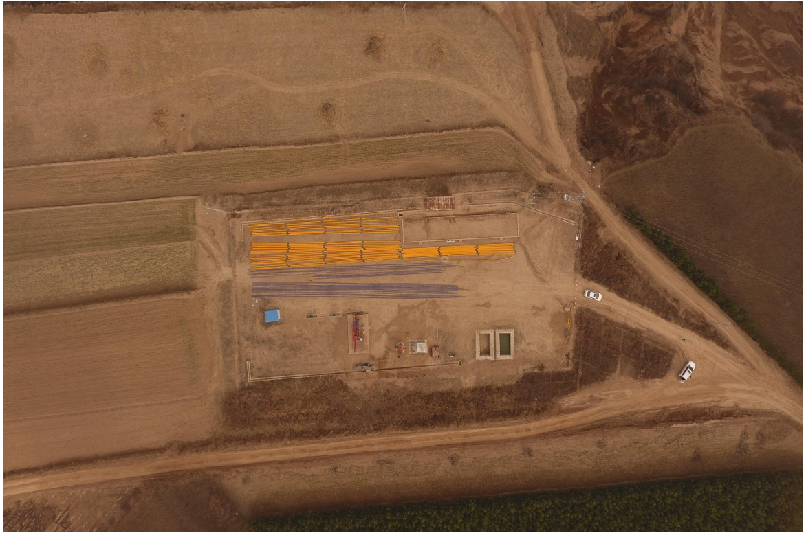
宁古 20 天然气井场航拍照片
