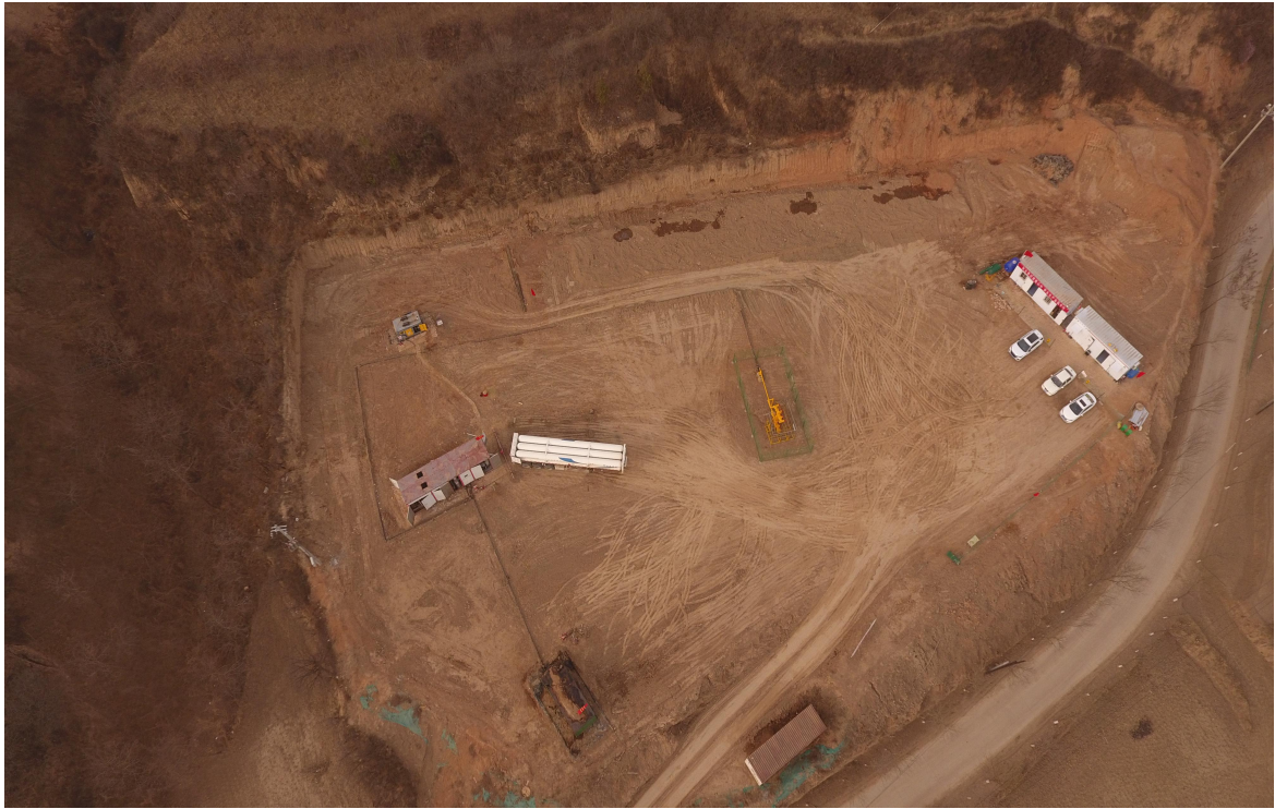
宁古 11 天然气井场航拍照片
