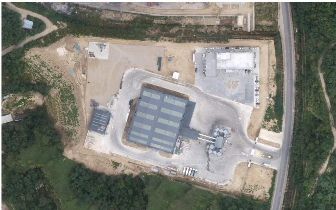
图 2-1 新建沥青混合料拌合站惠众商品混凝土生产线项目全貌图
