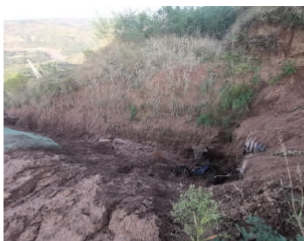
原有管道现状
