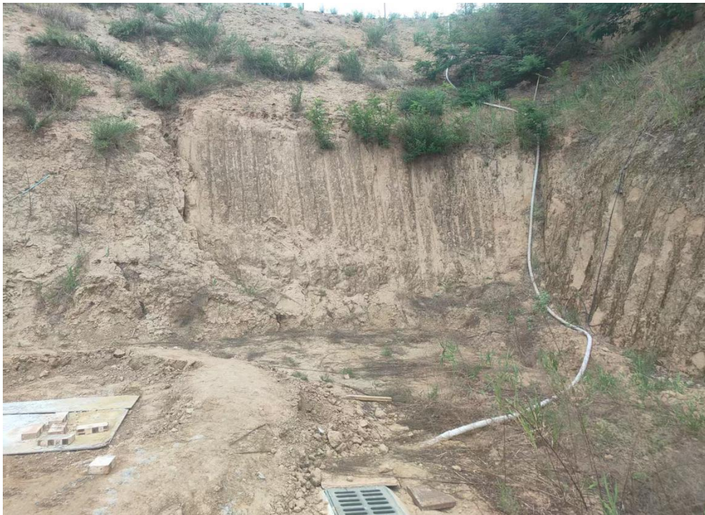
已建成渗滤液收集池
