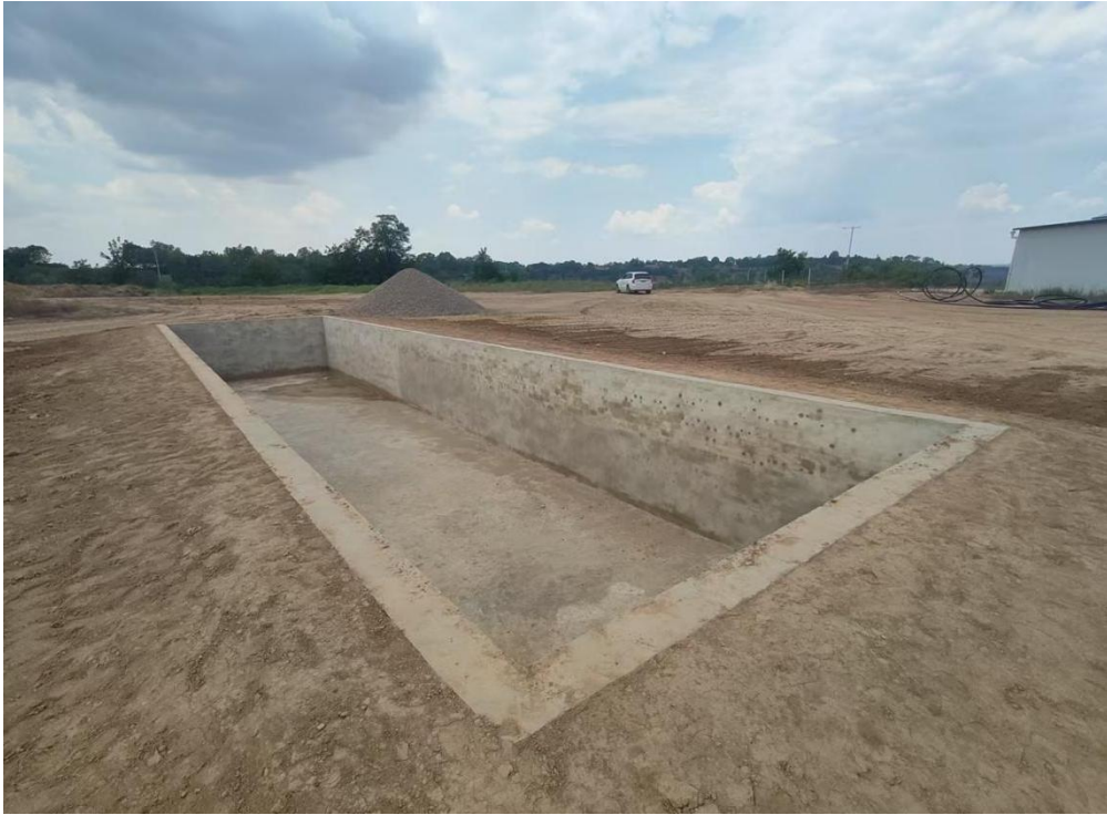
已建成蓄水池
