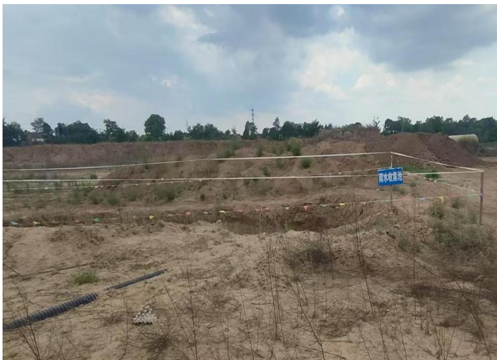
已建成临时蓄水池
